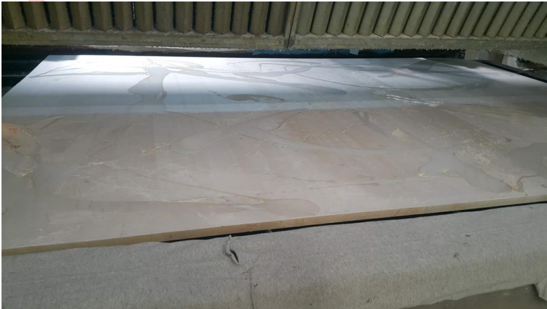
Şekil 3. Ön kurutma sonrası epoksi uygulaması
